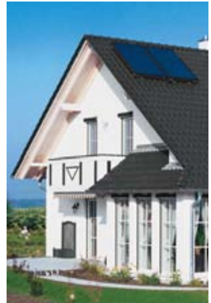
Aufdachkollektoren Doppelfeld vertikal zur Trinkwassererwärmung
