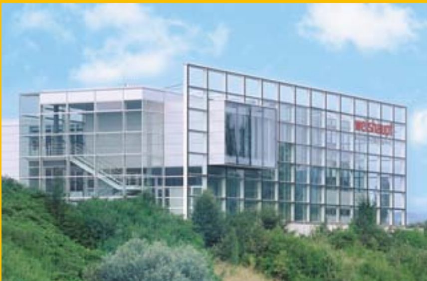
Schulungs- und Verwaltungsgebäude in Geroldswil (ZH)
