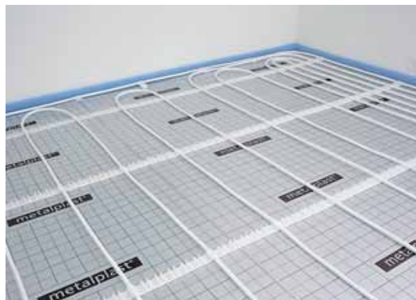
Fussbodenheizung Metalplast Standard. Vor dem Einbringen des Unterlagsbodens.
